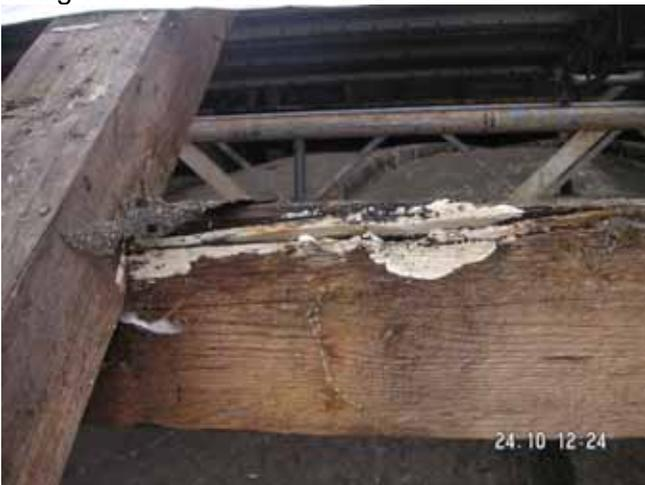
Der Dachstuhl benötigte umfassende Zimmermannsarbeiten, es musste viel angesetzt und verstärkt werden.
