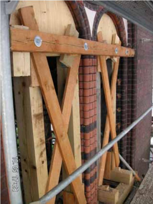
Zur Neuaufmauerung der Fenstersäule der Süd-Schallöffnung des Turmes mussten die oberen Bögen und das Okuli gesichert werden.
