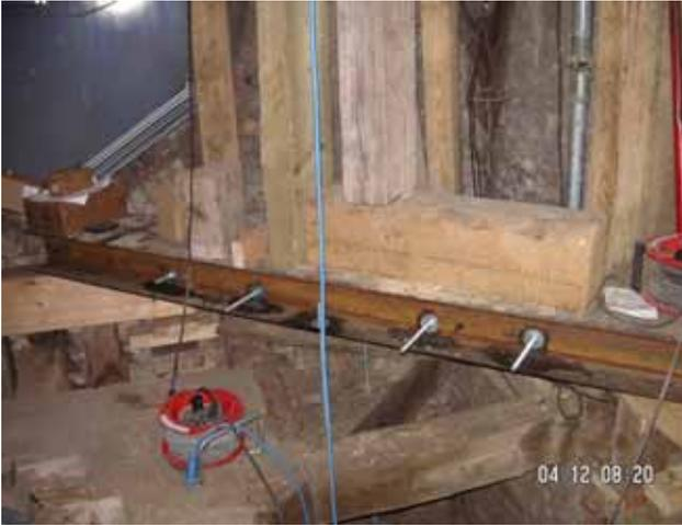
Abfangen des Turmhelmsstuhles zum Instandsetzen der Aufstandspunkte
