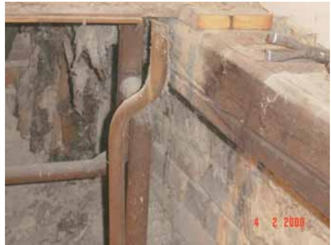
Massiver Hausschwammbefall im Emporenholz, der Dielungsaufbau musste in großen Bereichen, besonders auf der Nordseite, erneuert werden.
