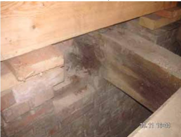
Die Aufstandspunkte des Turmhelmes sind durch Würfelbruch zersetzt.
